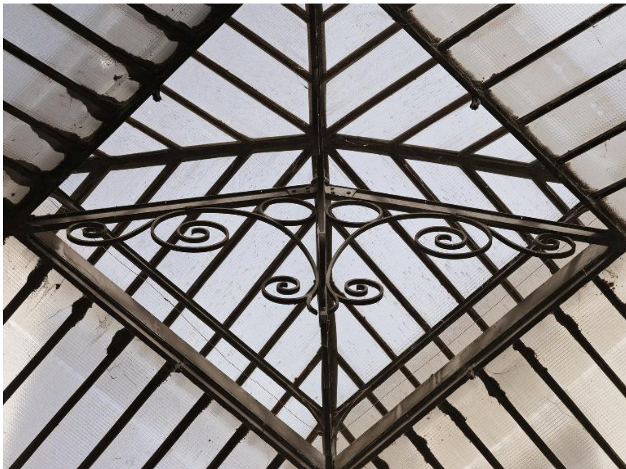
Cour, verrière zénithale, détail du lanterneau
