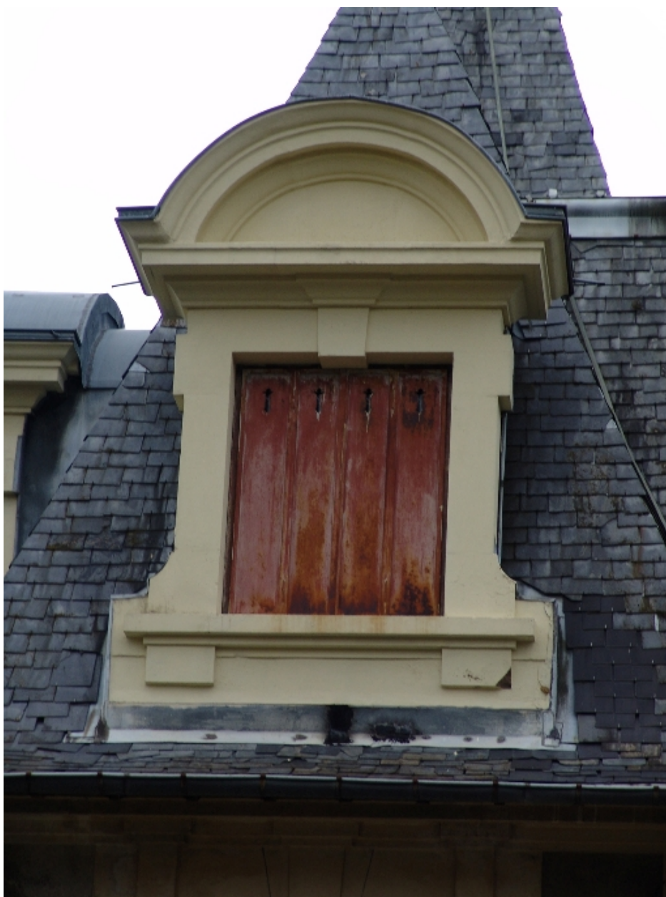
Détail d'une lucarne
