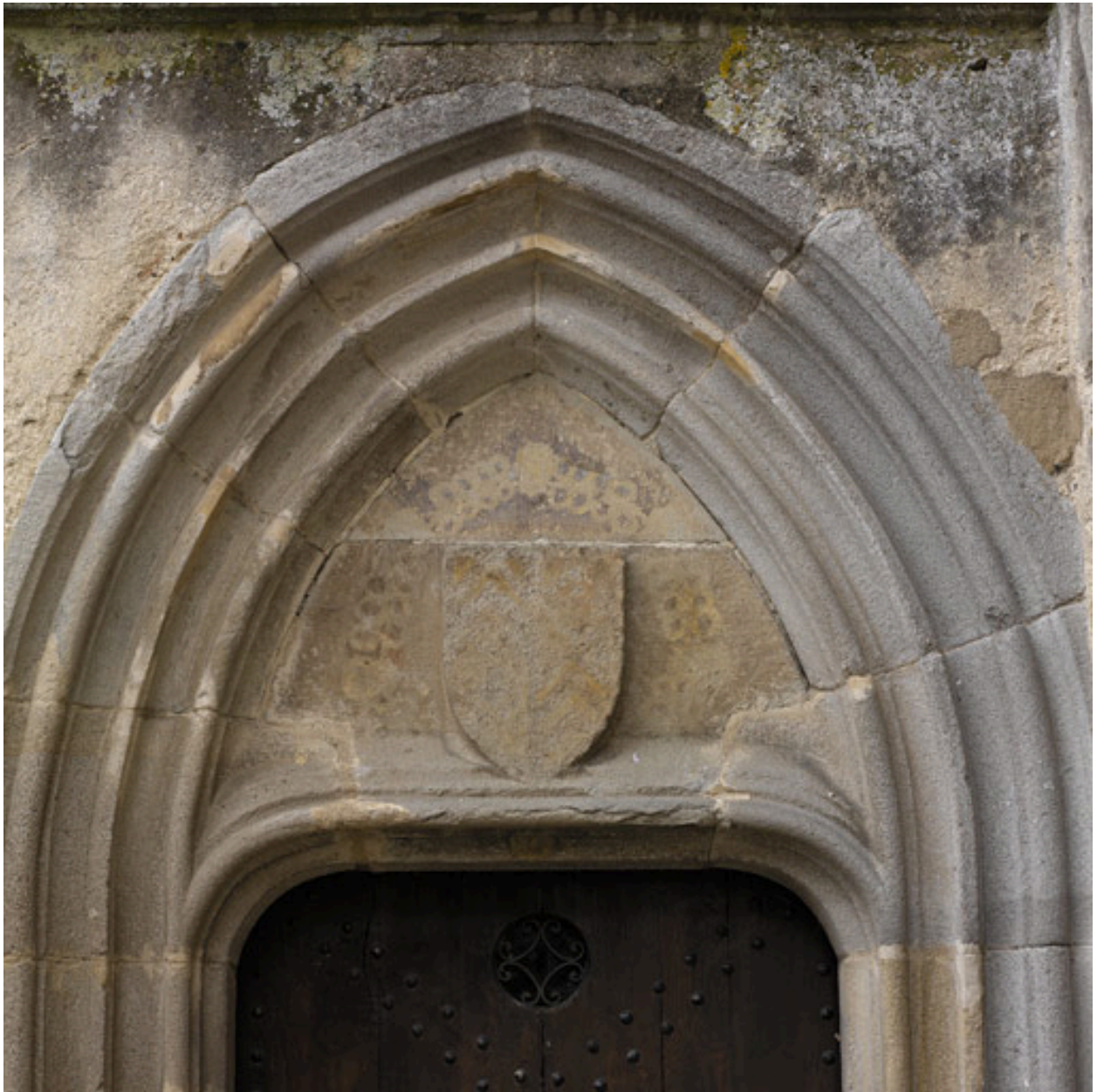
Détail de la porte de l'escalier en vis (angle des ailes sud et ouest, sur cour).
