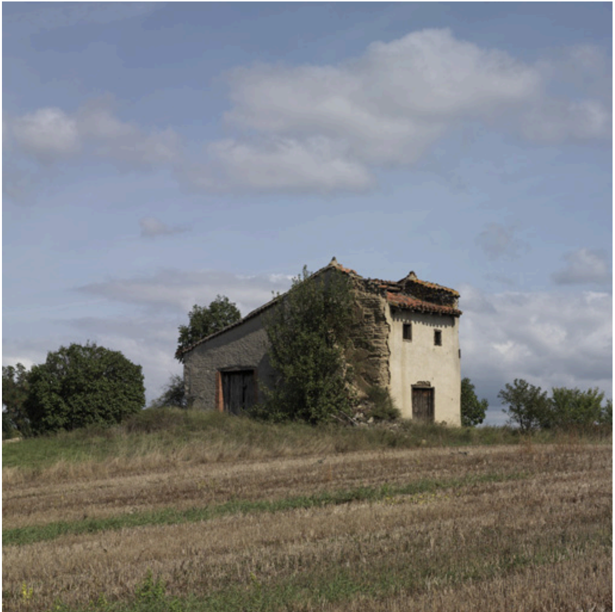
Vue générale depuis le sud-ouest.
