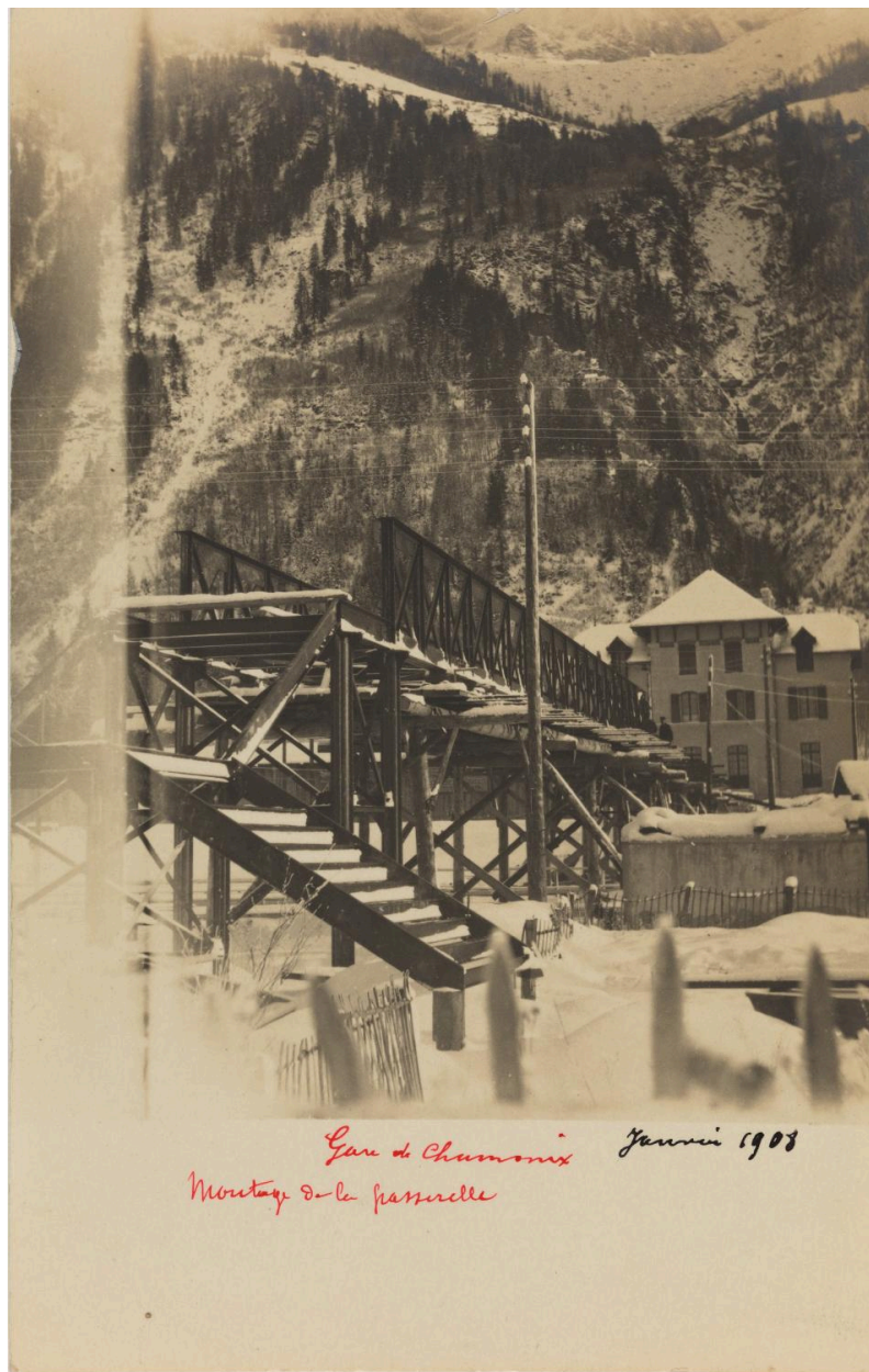
Gare de Chamonix, montage de la passerelle. 1908 (AD Haute-Savoie : 36 Fi 539)
