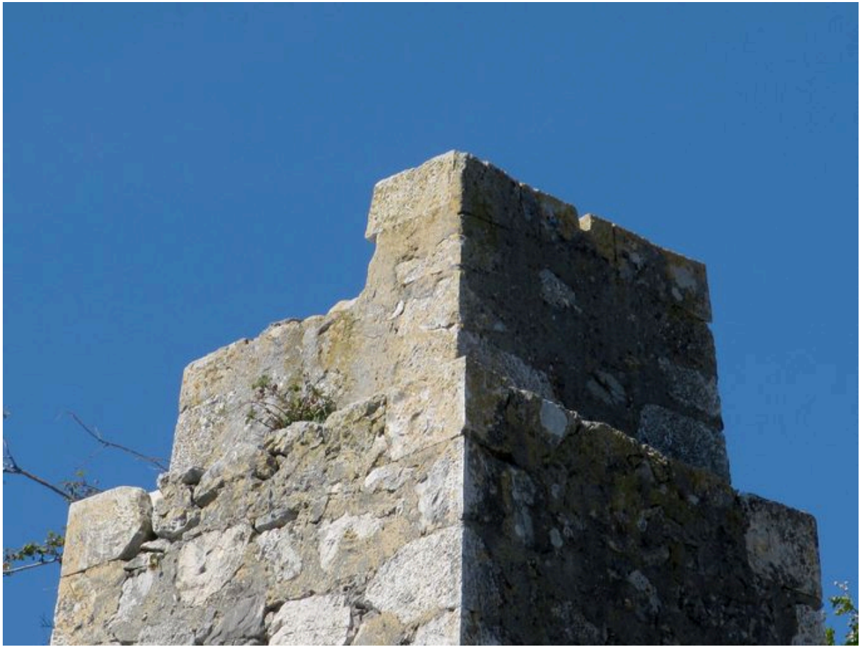
Vue de la partie sommitale de la pile (angle nord-est)
