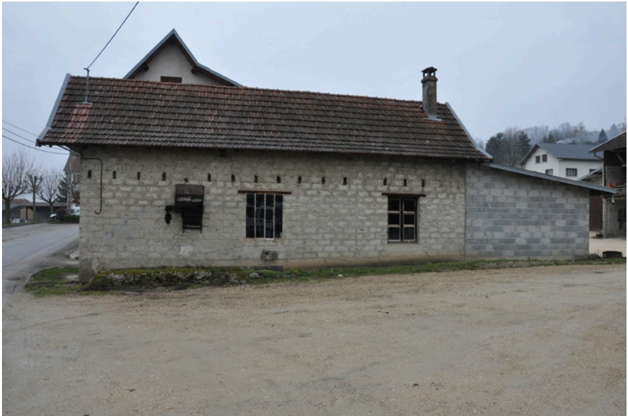
Vue de la forge, façade sud-est
