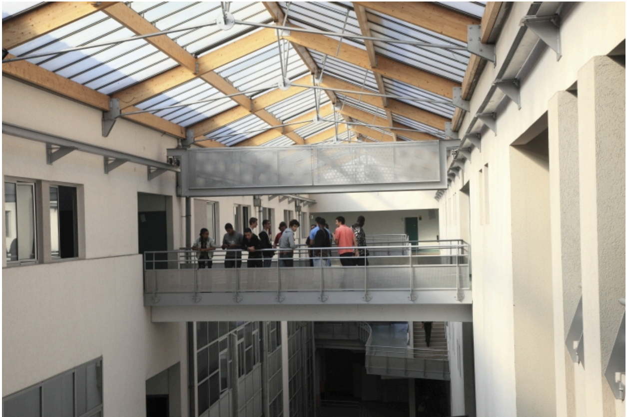
Bâtiment des ateliers techniques. Passerelle de liaison ; éclairage zénithal naturel.
