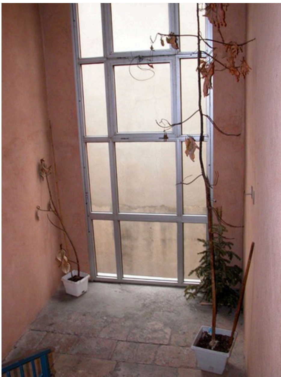
Vue de la fermeture de la cage d'escalier, ancienne cage ouverte
