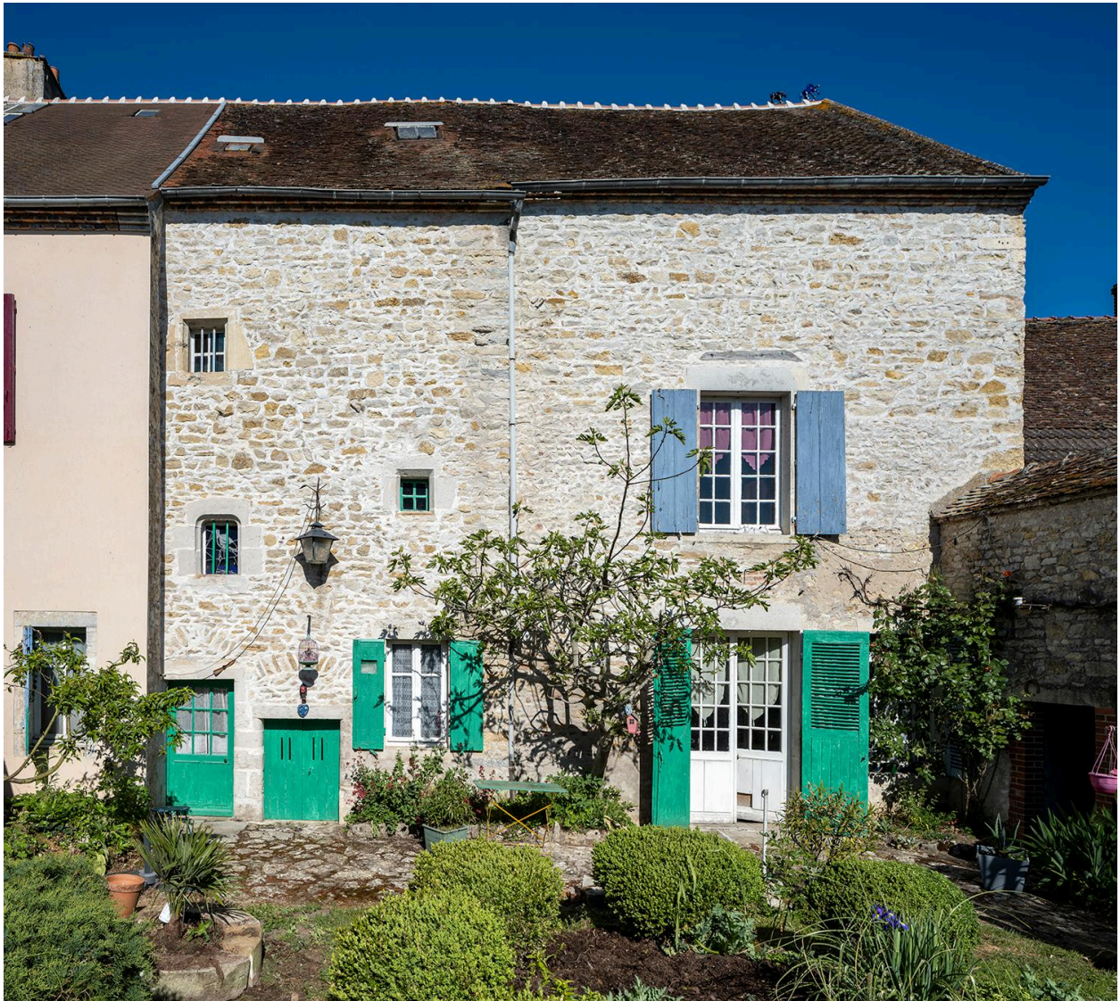
Vue de la façade orientale de la maison.
