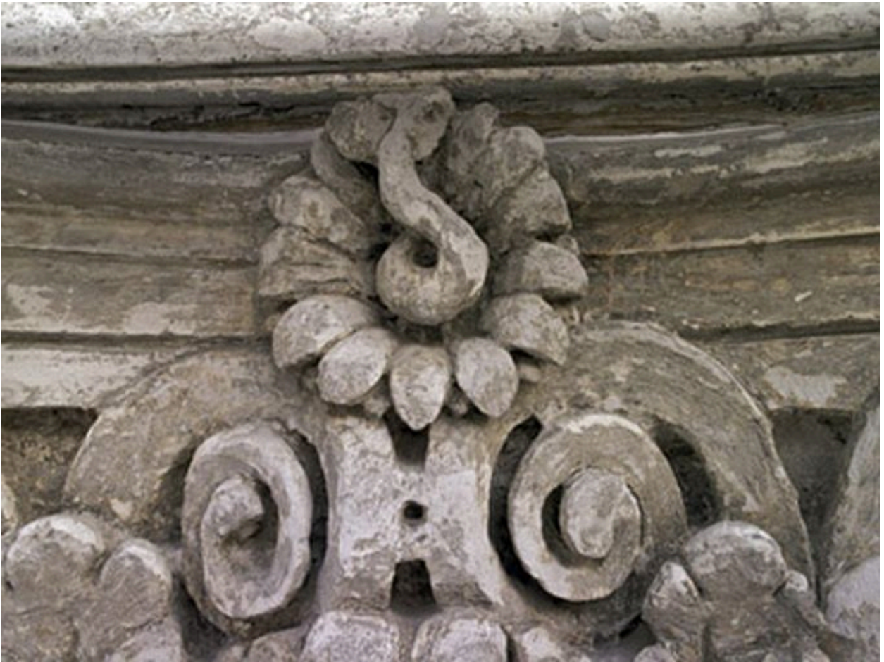
Elévation postérieure, rue Royale : chapiteau corinthien, détail
