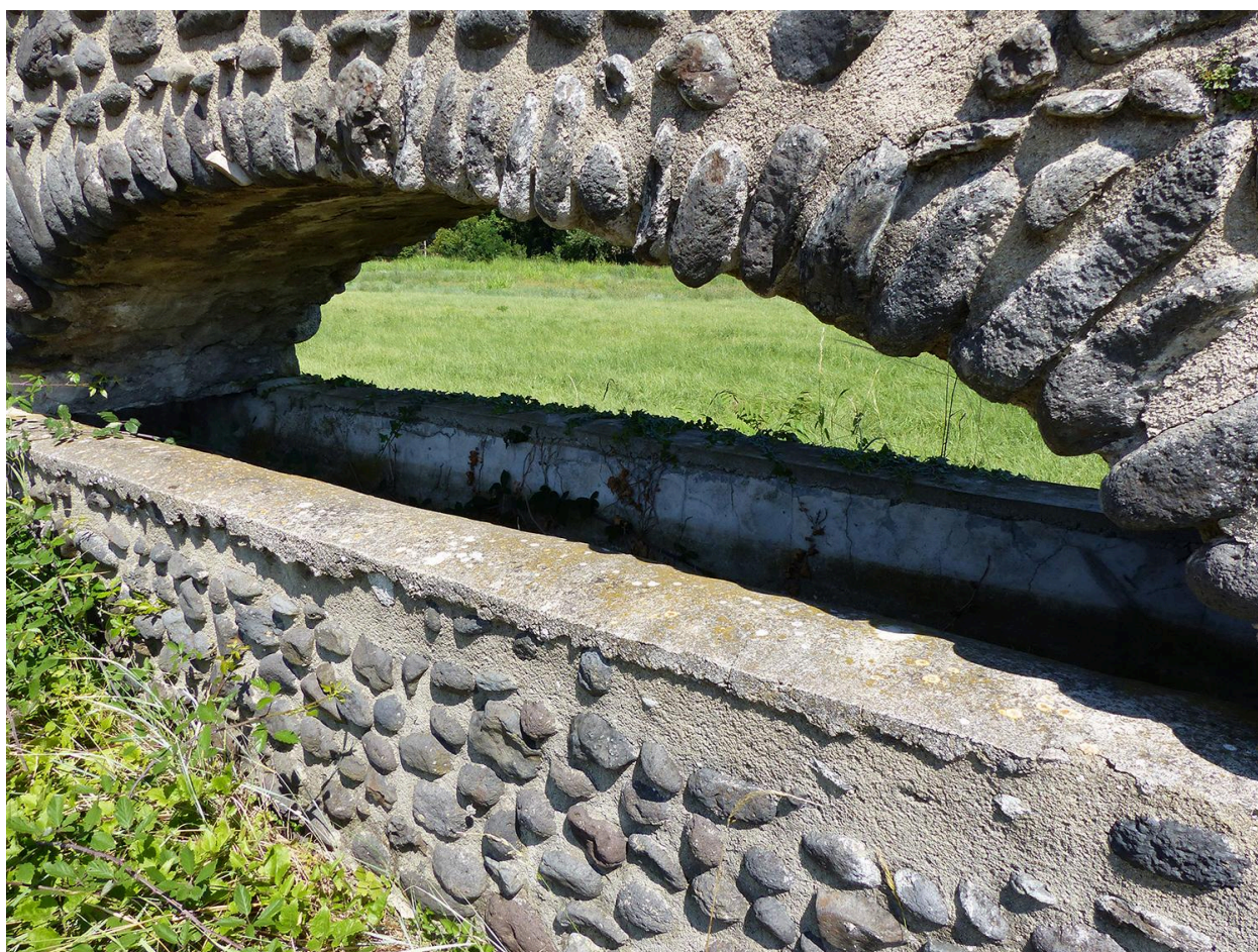
Détail arche aqueduc
