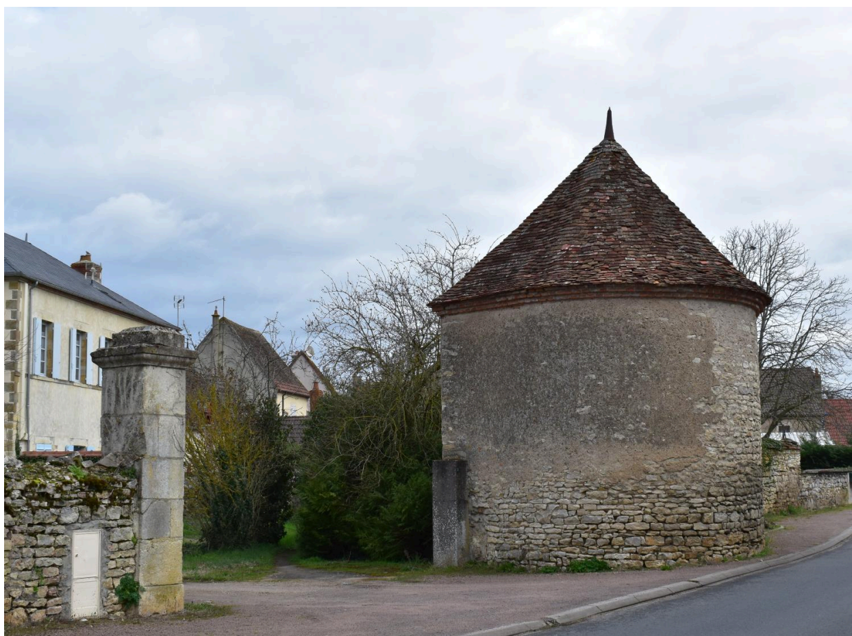
Tour, vestige de la fortification d'agglomération du Veudre, parcelle cadastrale B01 :123, donnant sur la rue Tour des murs. Vue vers le nord.
