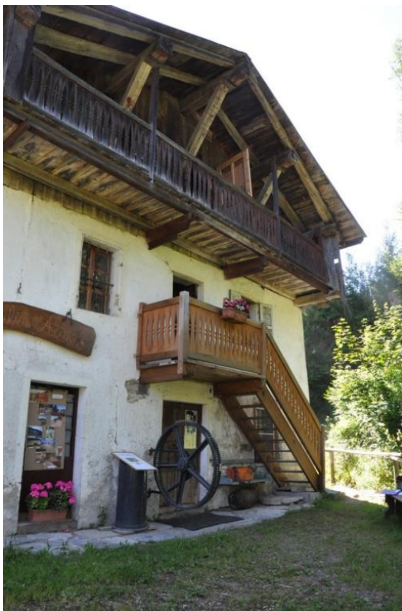
Pignon ouest du moulin.
