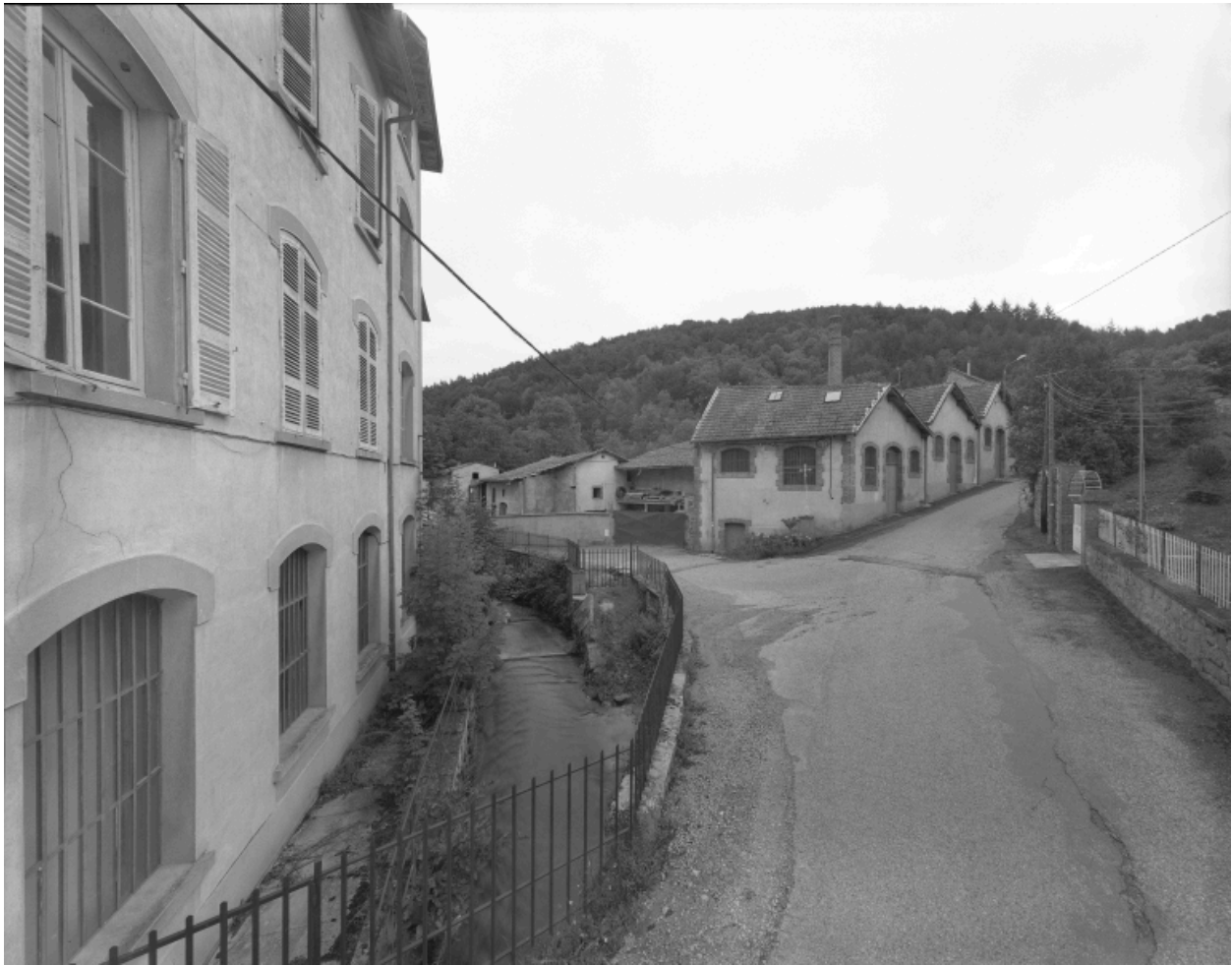
Vue partielle du bief alimentant les turbines de l'usine Giron et vue d'ensemble des sheds des ateliers construits en 1901.
