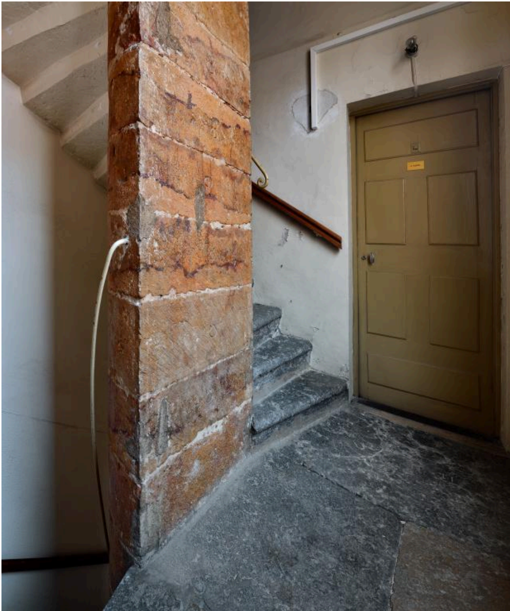
Escalier secondaire est : noyau et palier
