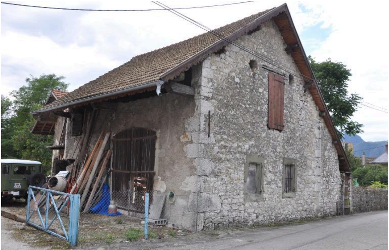
L'ancienne remise agricole, vue de trois-quart depuis le nord-est
