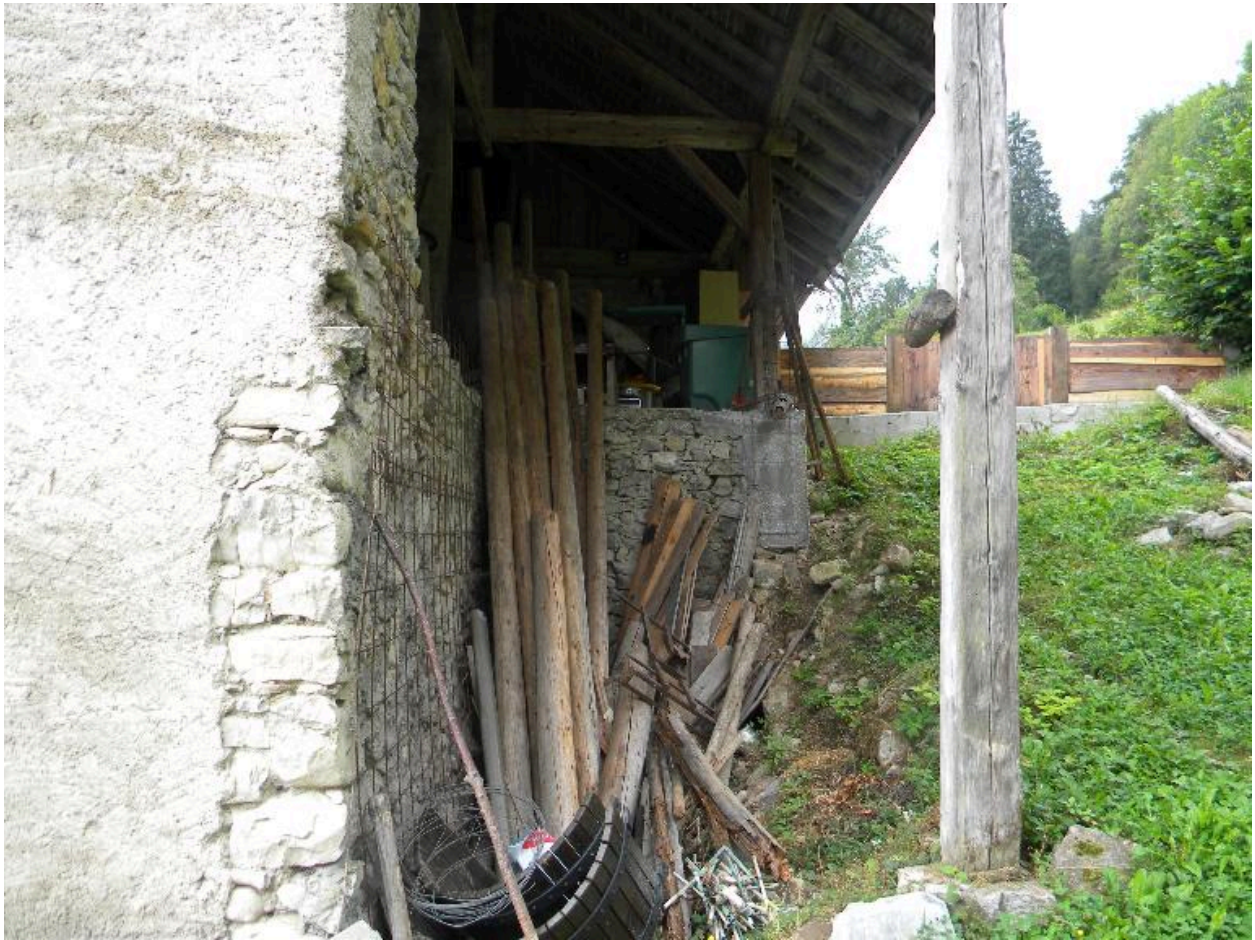
Vue de la façade arrière.
