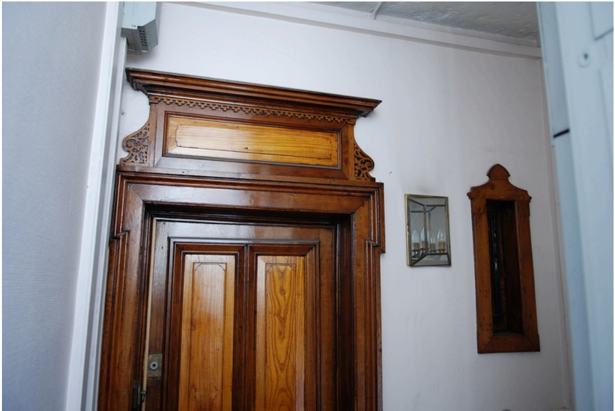
Porte palière et fenêtre de second jour
