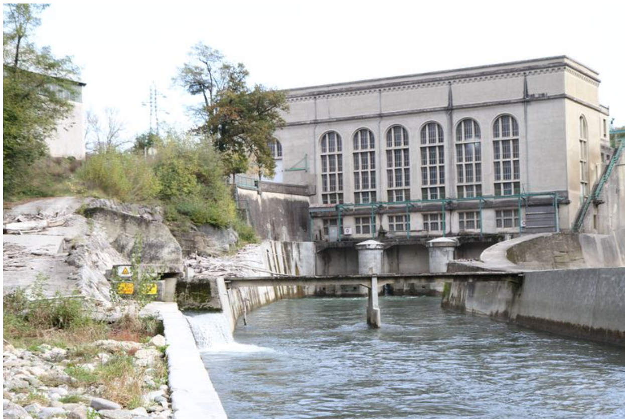
Vue de l'usine prise depuis le canal de fuite
