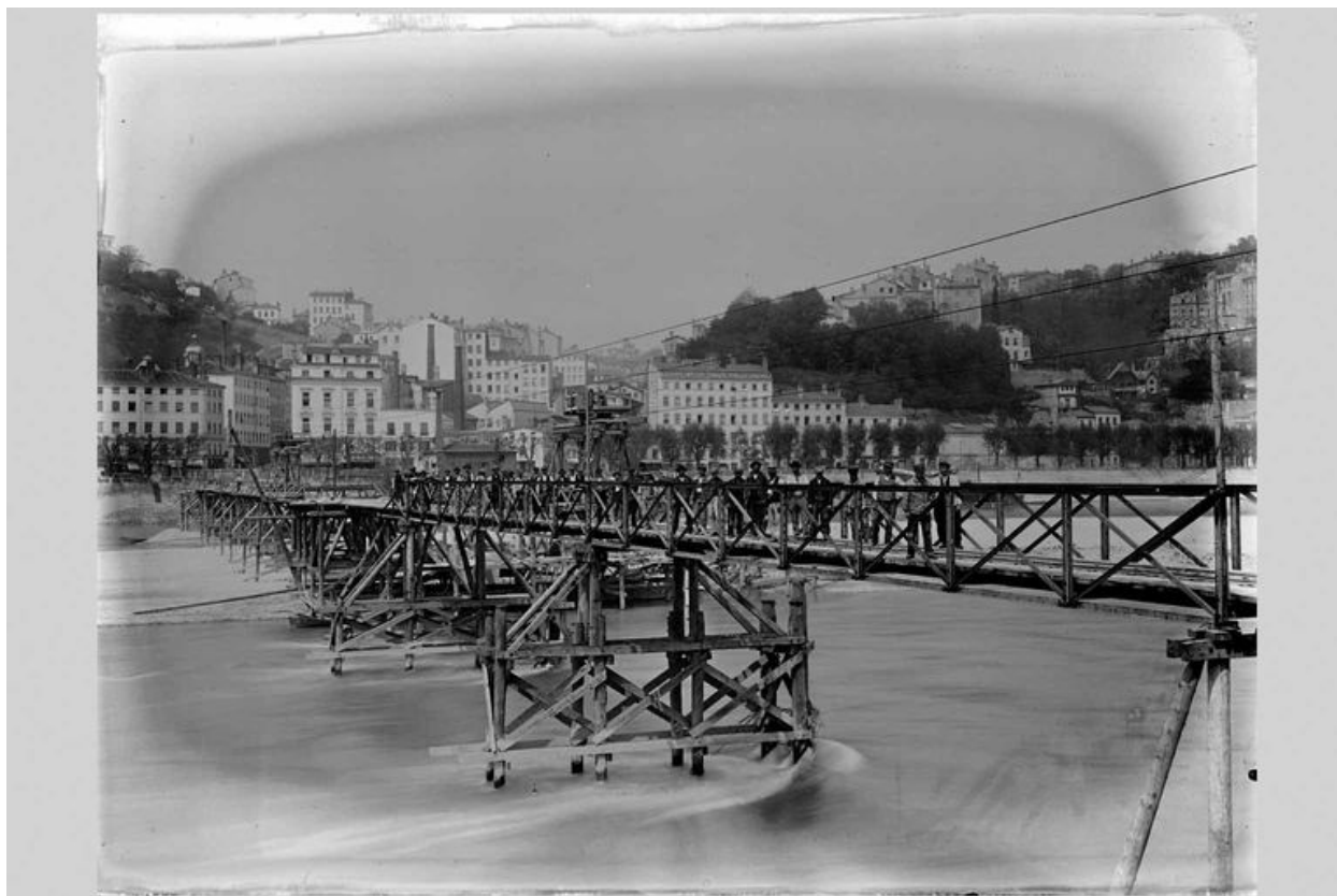
La construction du pont de la Boucle. Charpente de soutien des premiers éléments du tablier. Photogr., [1902] (Arch. mun. Lyon. 15 Ph 1795)
