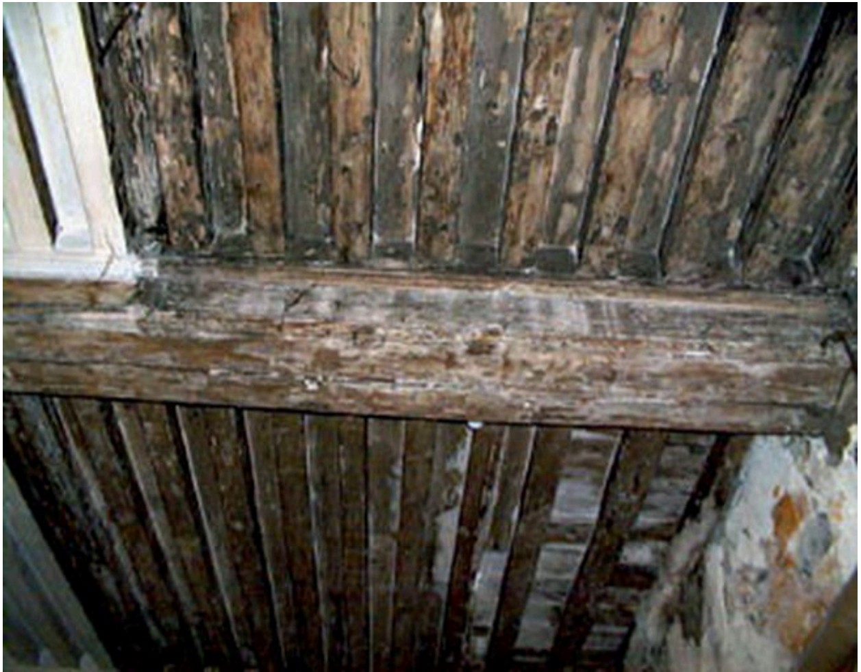
Plafond du rez-de-chaussée du corps de bâtiment ouest
