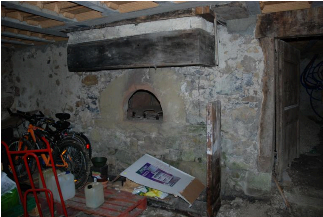
Vue intérieure de l'étage de soubassement : four à pain.
