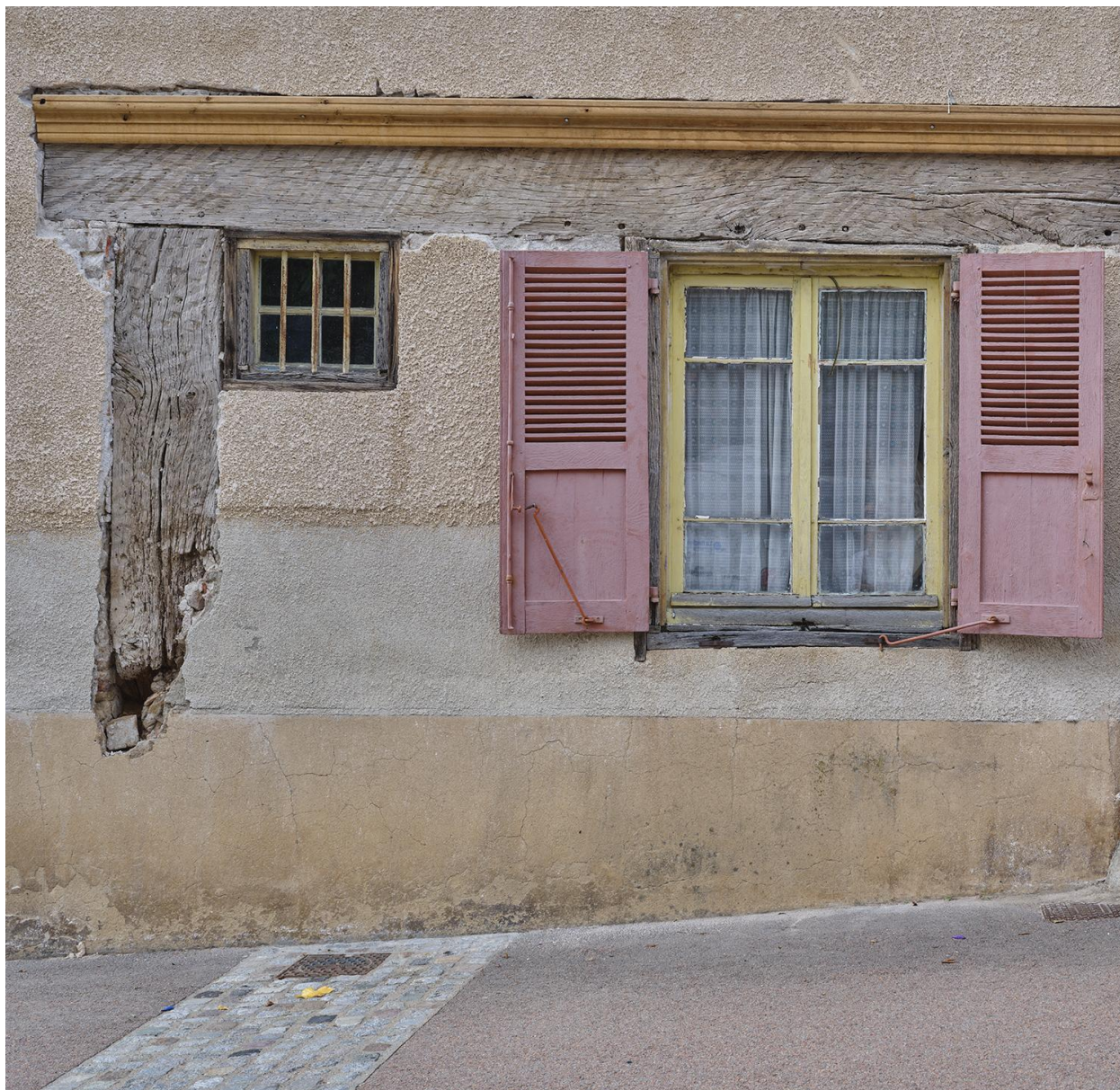
Elévation sud de la maison, détail des encadrements en bois des baies du rez-de-chaussée
