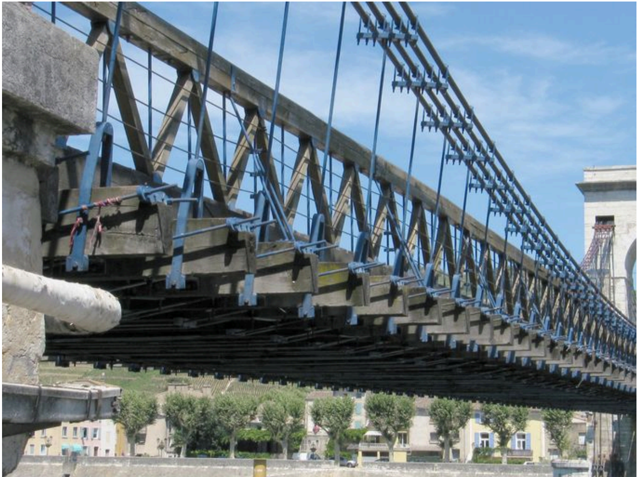
Travée droite, face aval, vue partielle : jonction des suspentes avec le tablier (depuis la rive droite)
