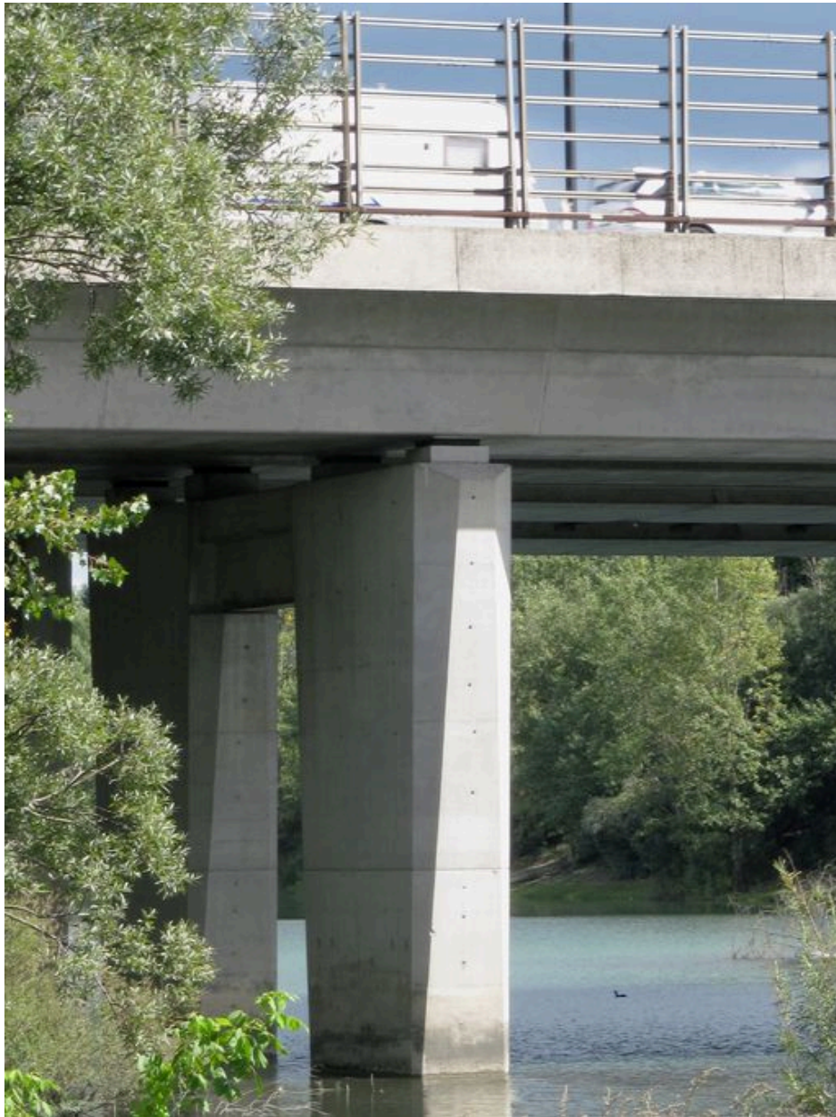
Piles (depuis la rive droite, aval)
