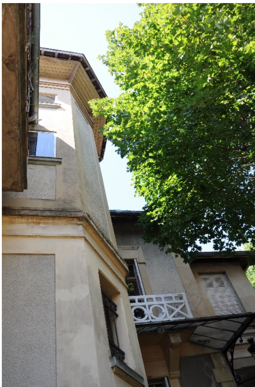
Vue de la tour par en-dessous
