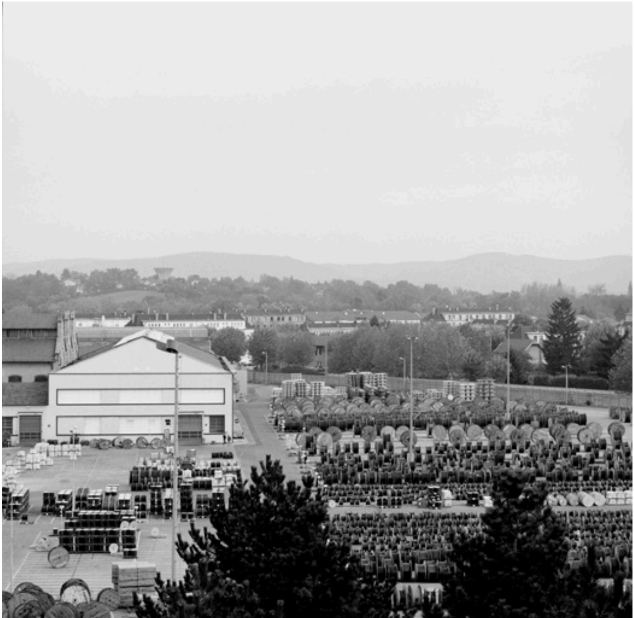
Vue des stockages extérieurs
