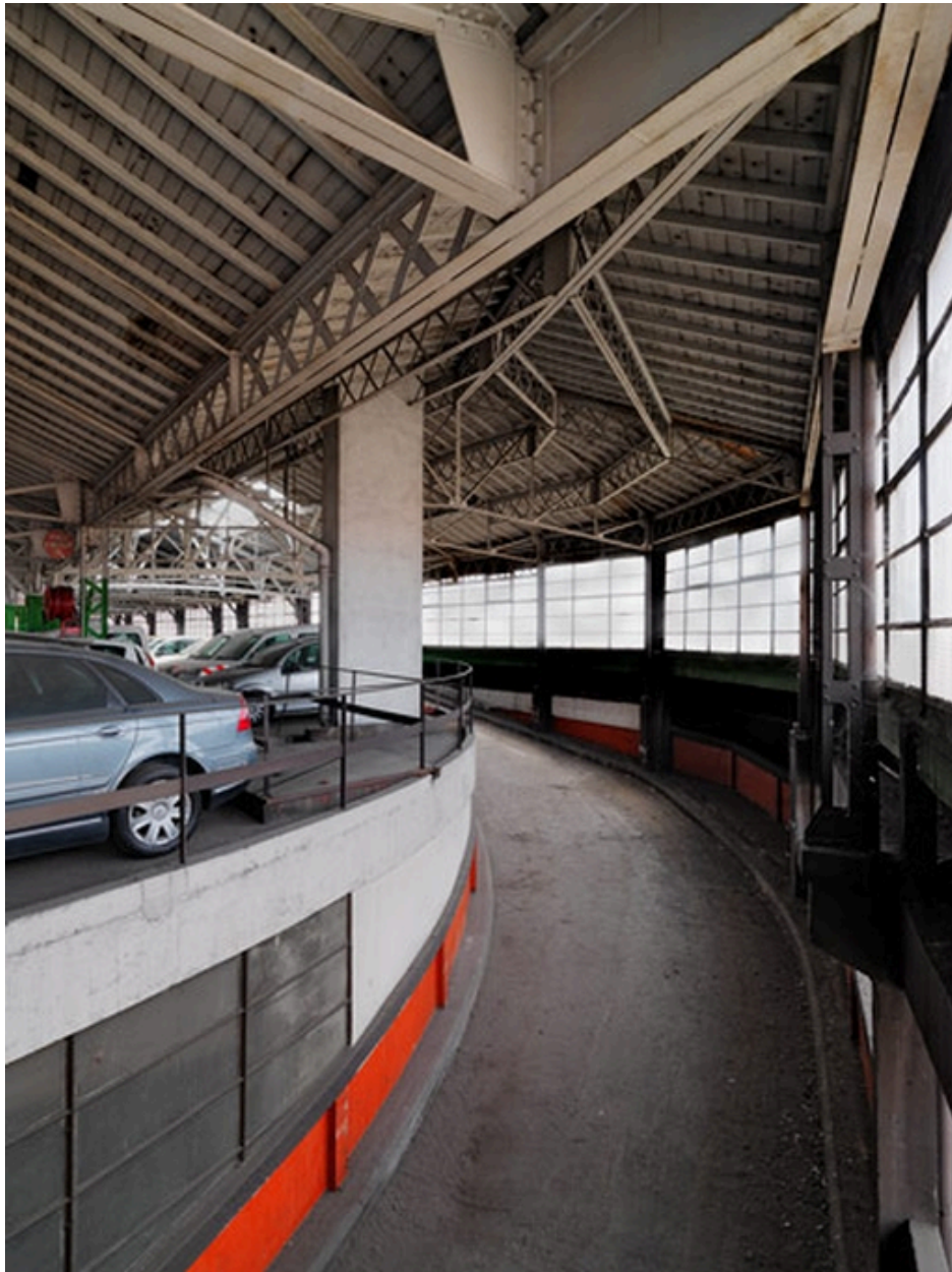
Vue rampe descendante (5e étage)
