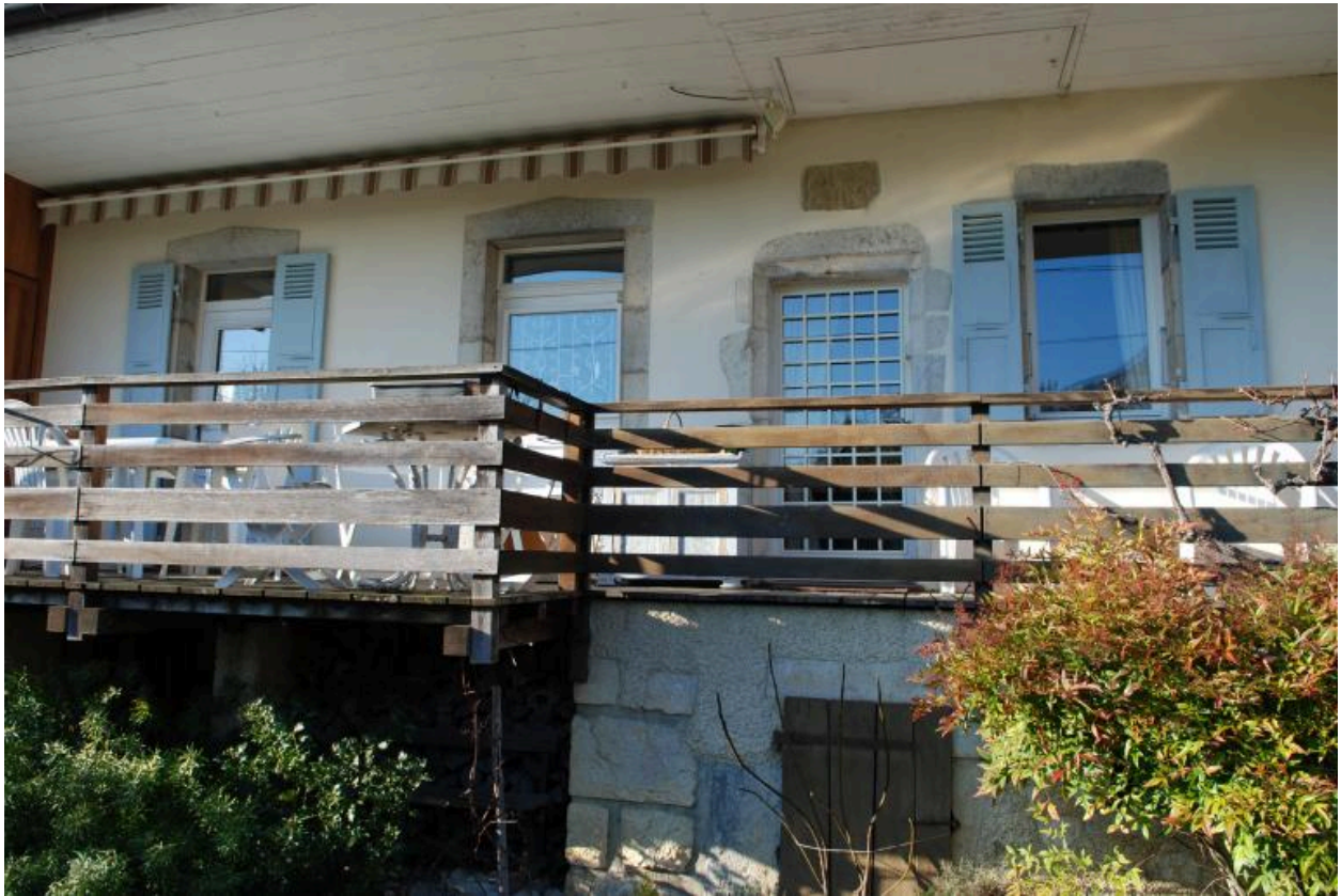
B7 1637, les Crêts-Nord, ferme. Détail de la façade avant du logis.
