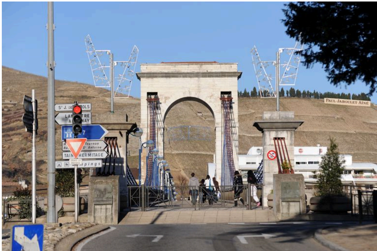
Vue générale, de dessus, massifs d'ancrage, pile centrale et voie piétonne (depuis la rive droite)
