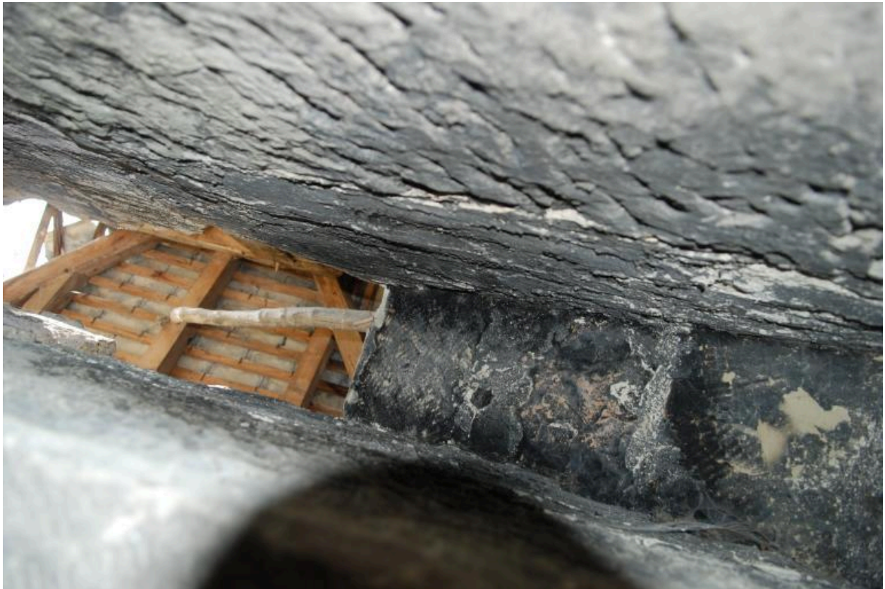
Vue du conduit d'échappement des fumées du four.
