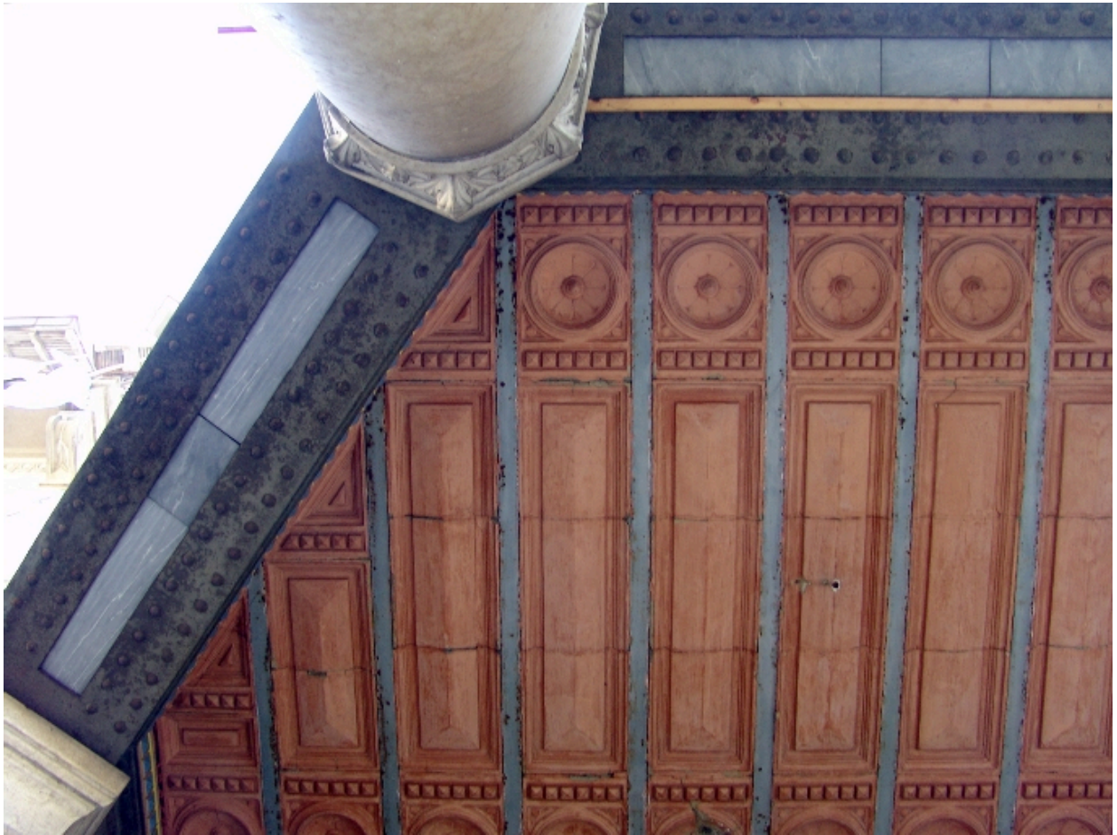
Couvrement du porche, détail
