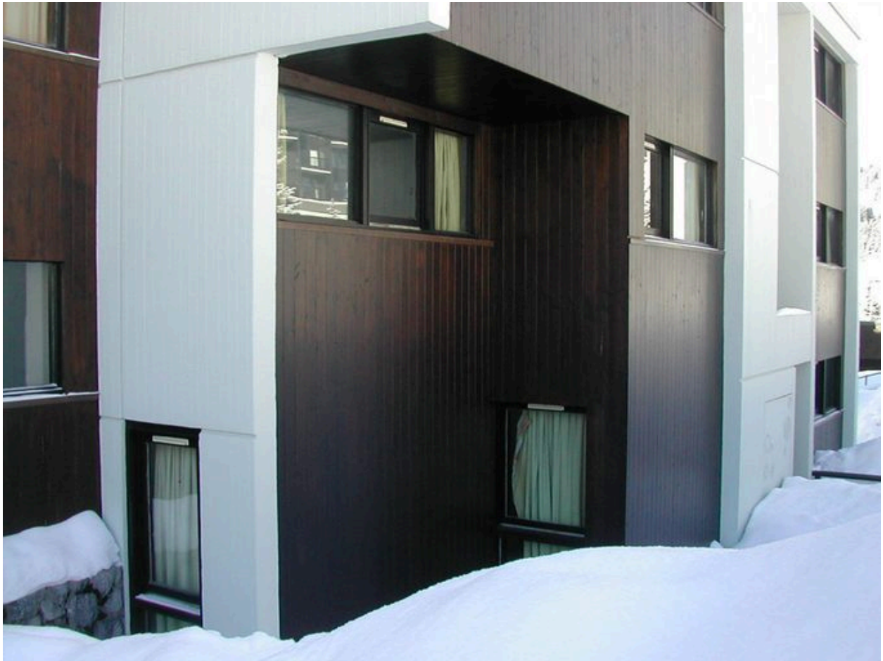
Elévation nord. Détail
