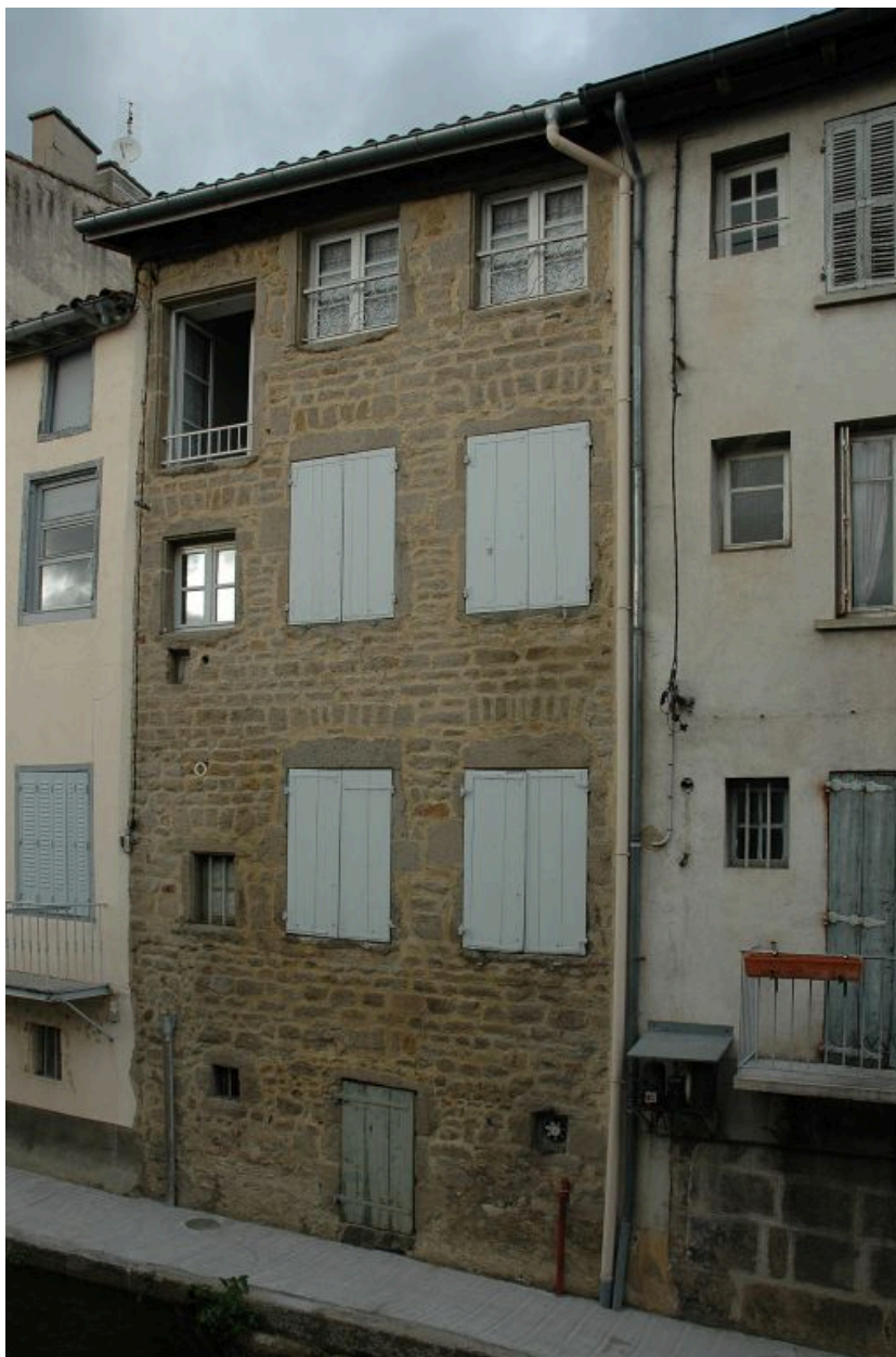
Elévation postérieure donnant sur le quai.
