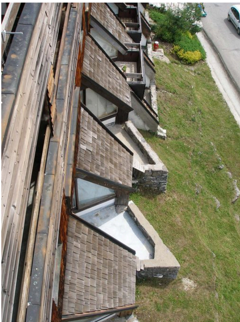
Les terrasses au bas de la façade aval
