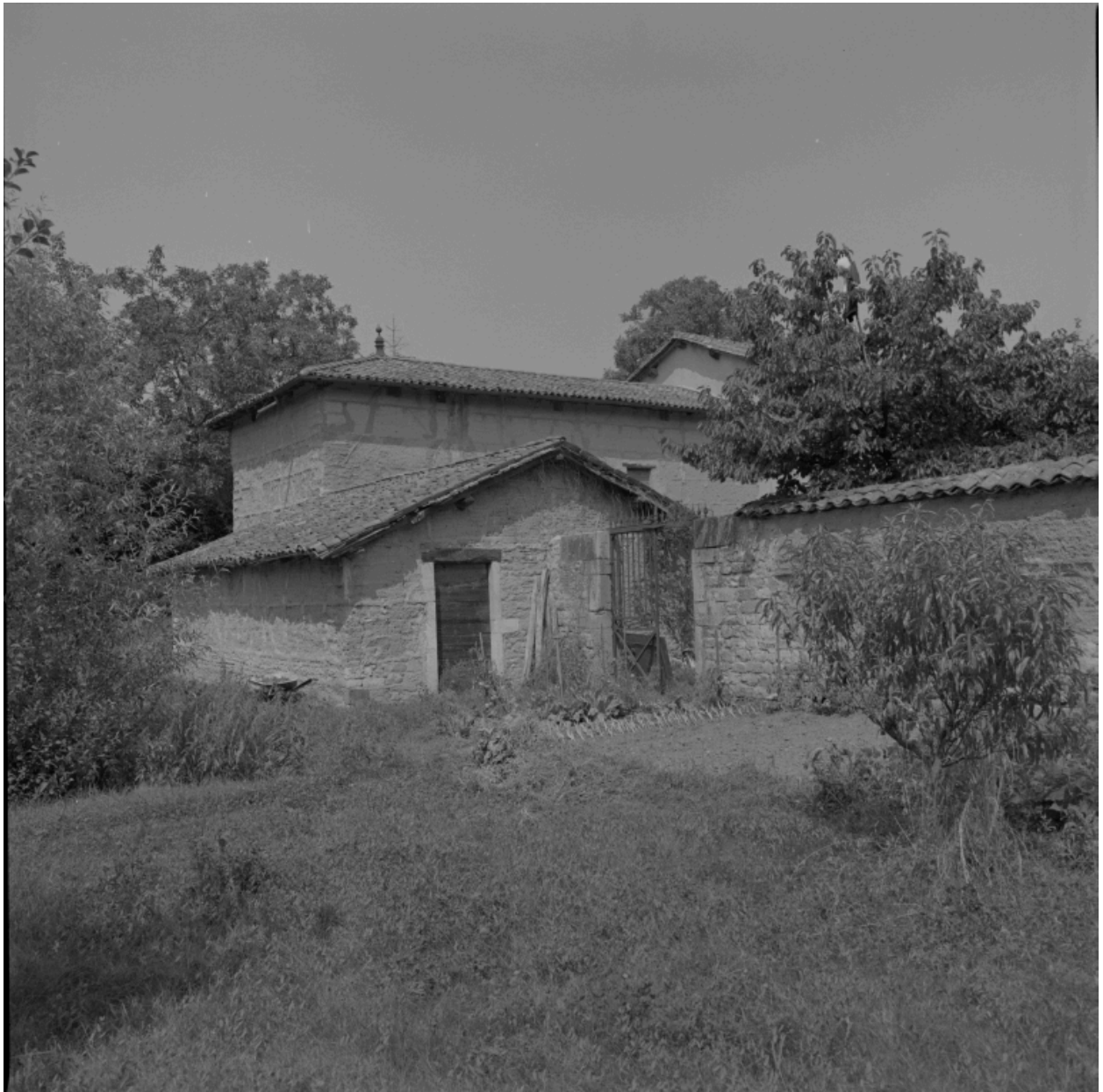
Petites dépendances, élévation postérieure et mur de clôture de la cour.
