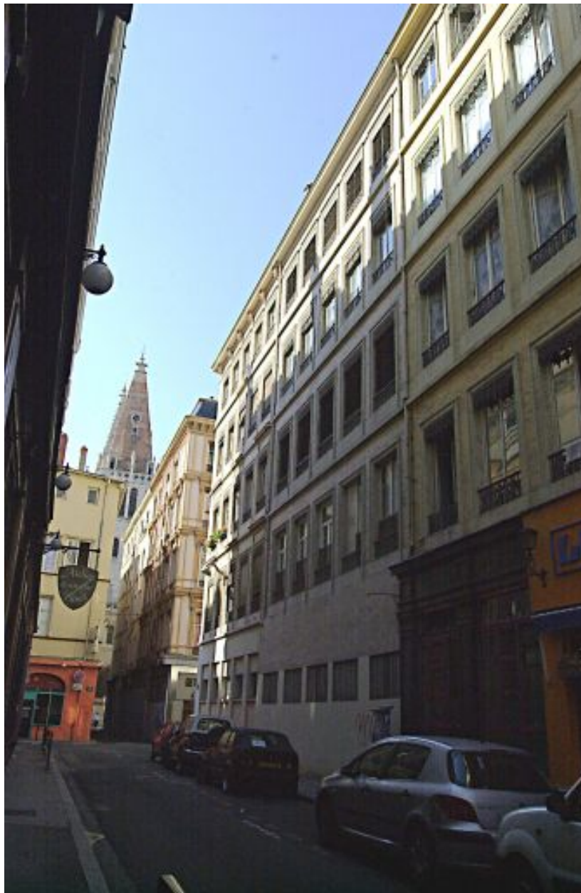
Façade sur la rue Pléney
