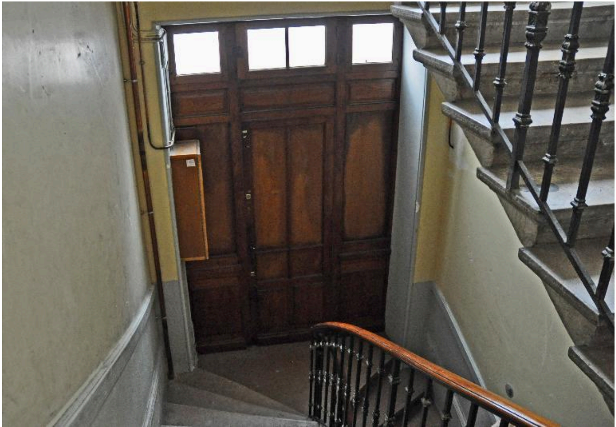
Vue intérieure : porte de la loge de concierge au niveau du premier repos
