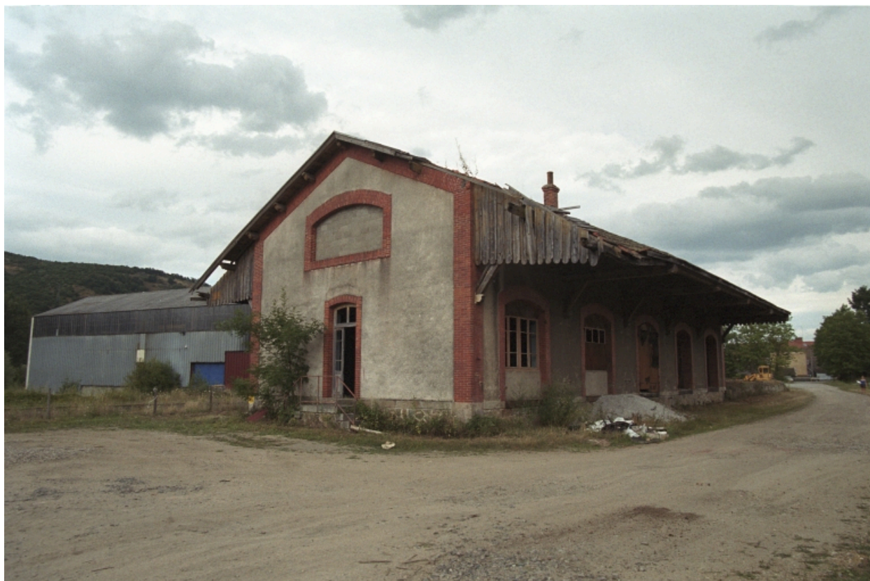
Sail-sous-Couzan, A la Gare, 1986 A 1067. Remise ferroviaire.
