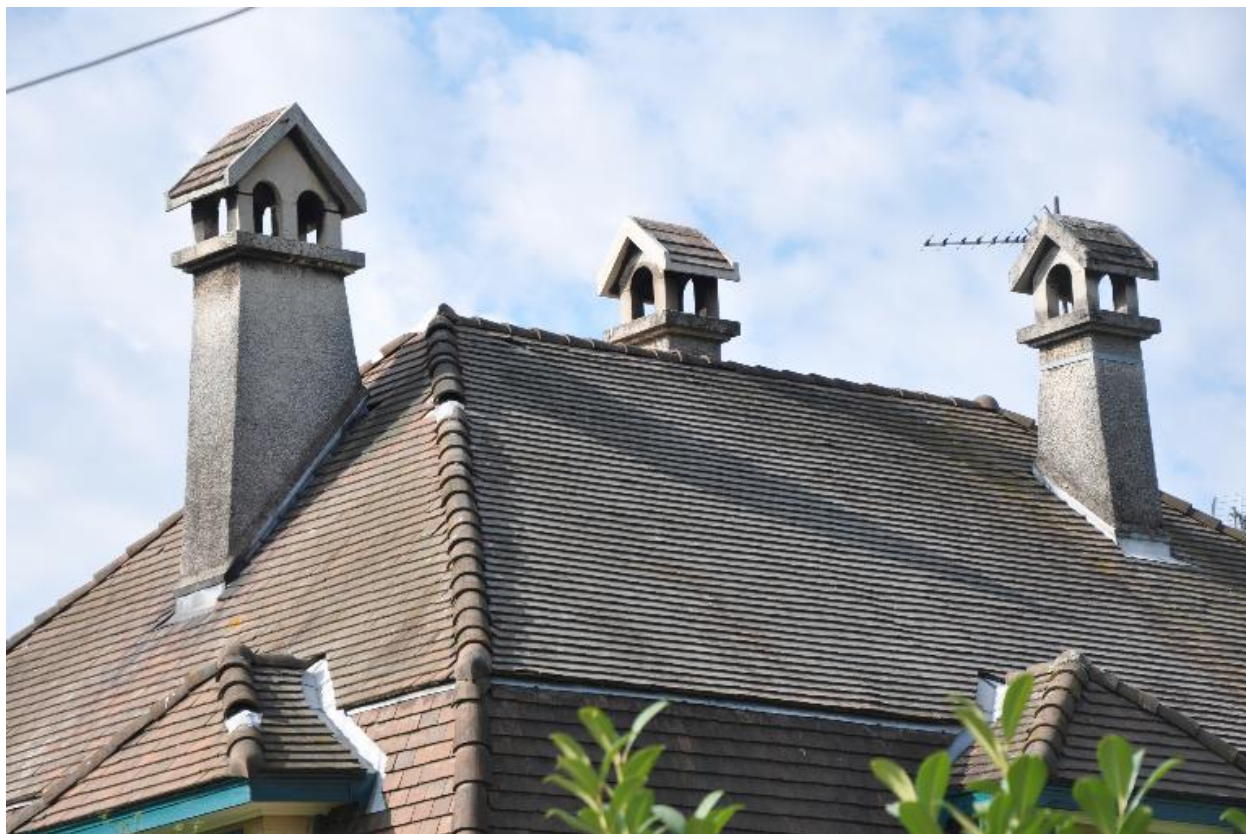
La toiture et les cheminées
