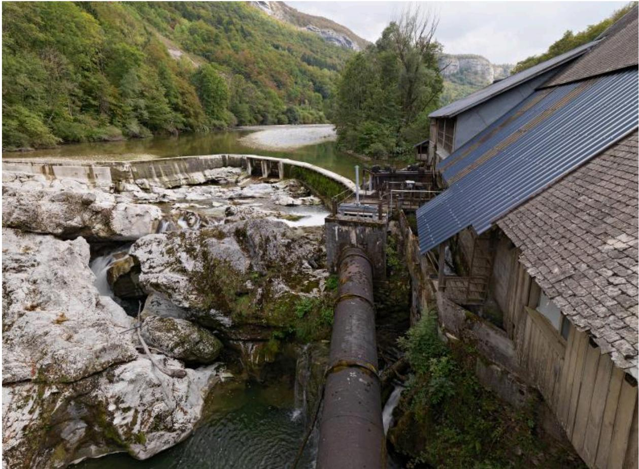
Barrage et arrivée d'eau le long de la scierie et dans la conduite forcée de la micro-centrale électrique.
