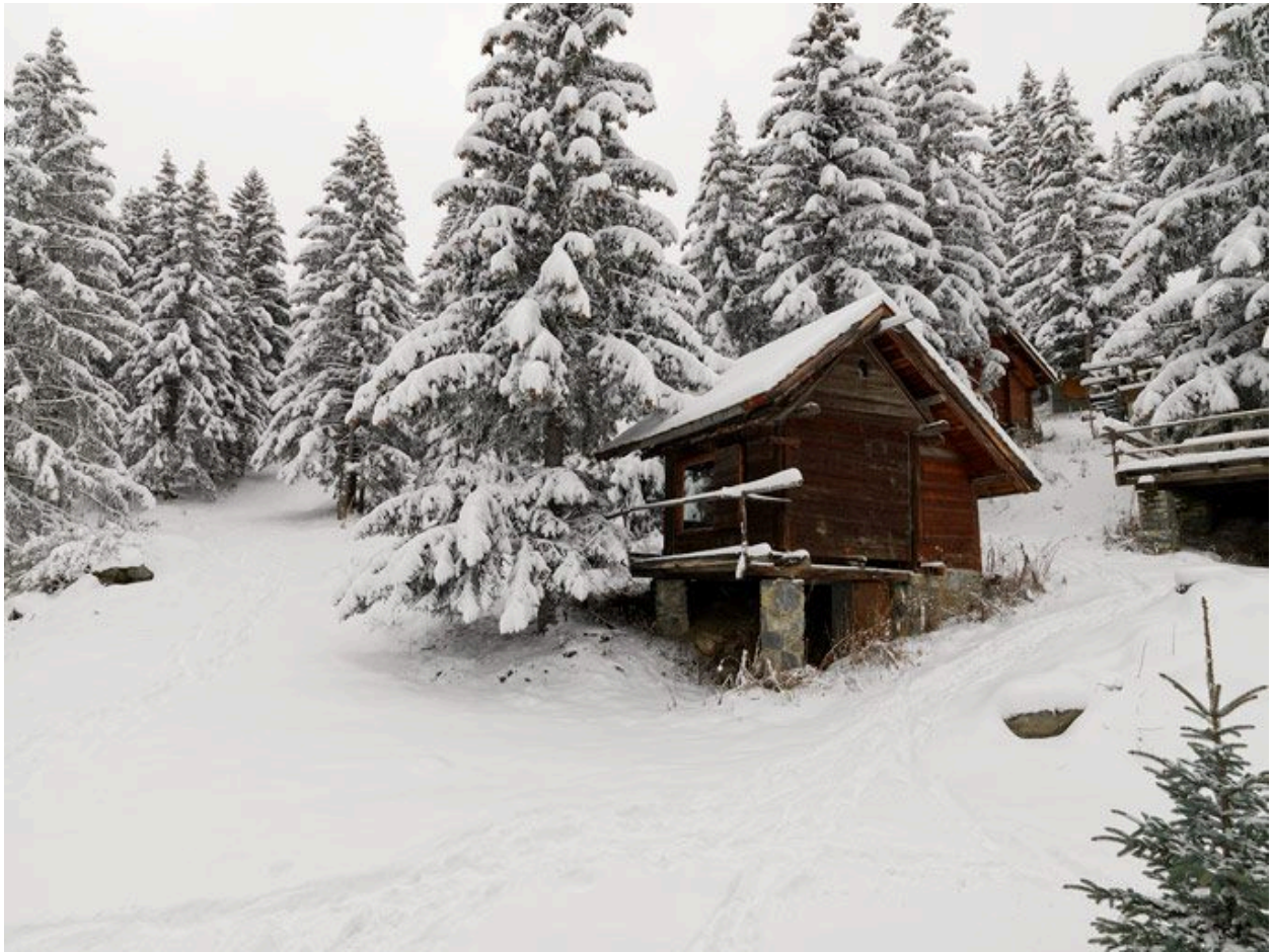
Élévation postérieure. Vue d'ensemble de 3/4 gauche
