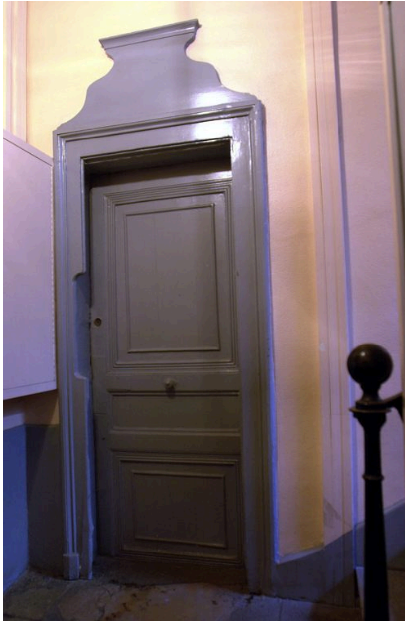
Porte palière du rez-de-chaussée
