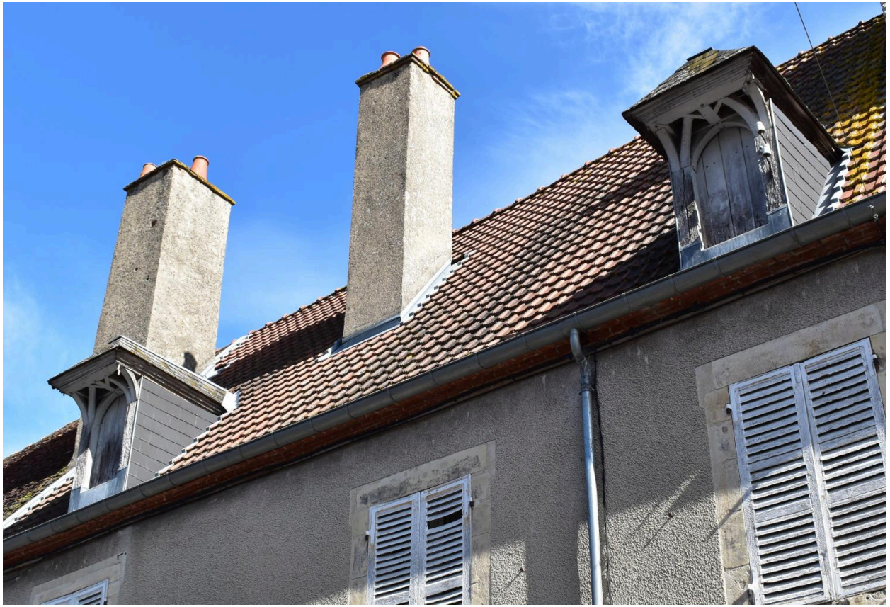
Vue des lucarnes charpentées, rue d'Allier.
