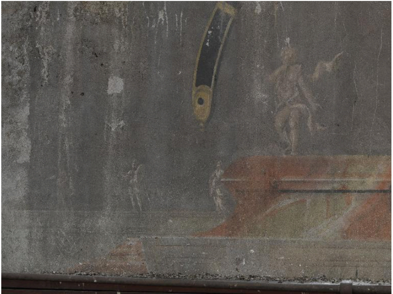
Mur ouest, partie centrale : détail de l'arrière plan
