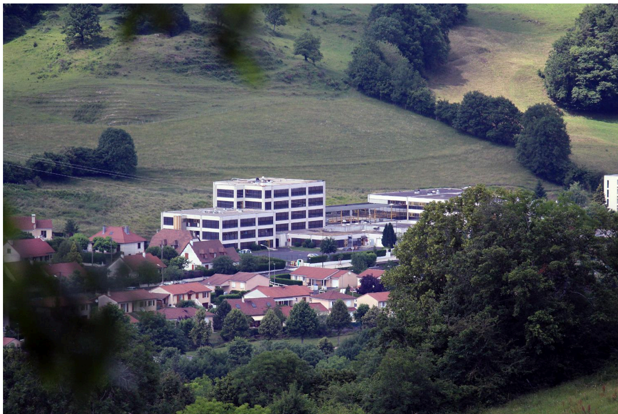
Vue générale en 2020, avant travaux
