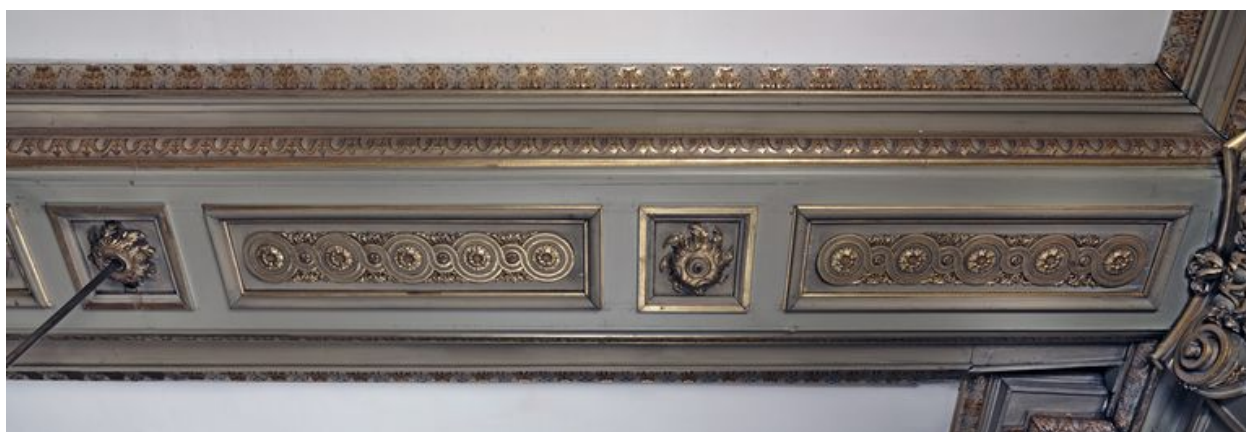
Rez-de-chaussée, bureau du recteur, détail d'une poutre
