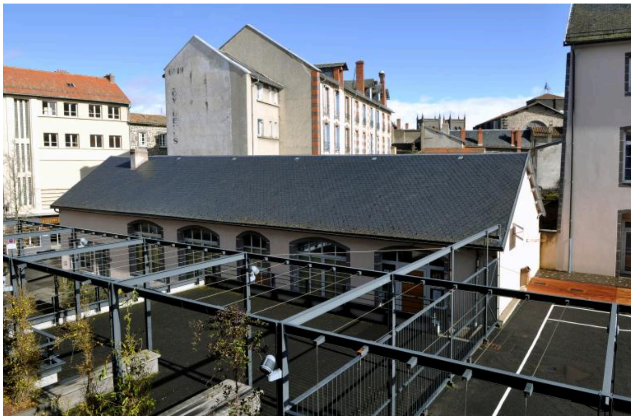
Gymnase, depuis l'ouest
