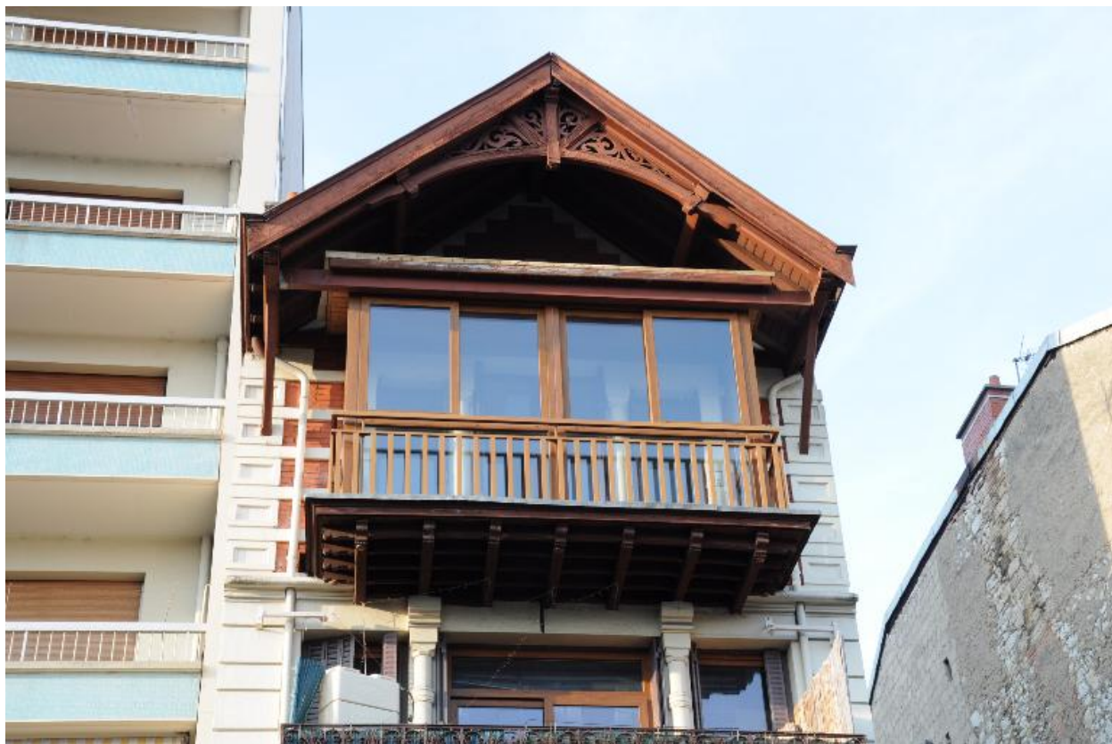
Le balcon-loggia ou oriel du 3e étage
